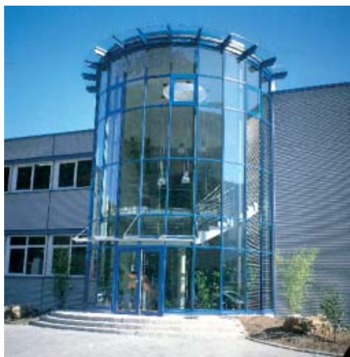
▲ Federnfabrik Baumann, Lichtenstein/D, System: VISS-TV (Architekt: Andreas Haid, Reutlingen/D)
