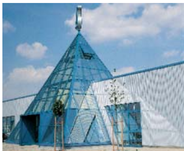
Zentrum für Orthopädie, Döbeln/D, System: VISS-TV 1S (Architekt: Ing.-Büro für Stahlbau, Dresden/D)
