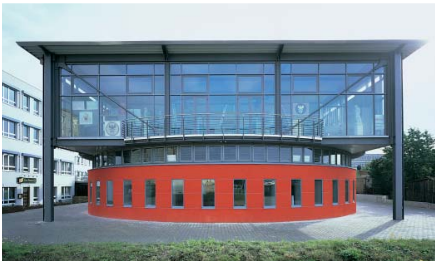
BBZ Baubildungszentrum, Magdeburg, System: VISS-TV, (Architekt: Pook + Leisker + Partner, Braunschweig/D)
